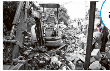
ごみ屋敷の片付け作業
